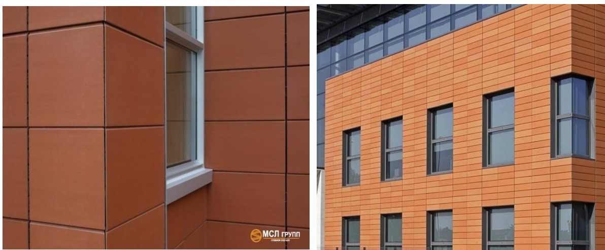
Рис. 6. Применение крупноразмерных облицовочных керамических плит для фасадов зданий
