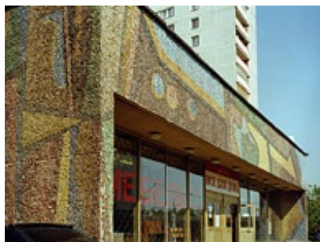
Рис. 30. Смальта: а – внешний вид; б – пример отделки фасада смальтой
