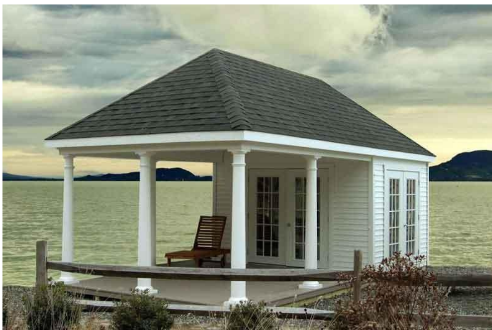
Рисунок 4.3 – Вид здания с четырехскатной кровлей
