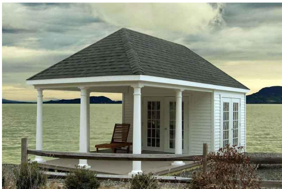
Рисунок 4.3 – Вид здания с четырехскатной кровлей
