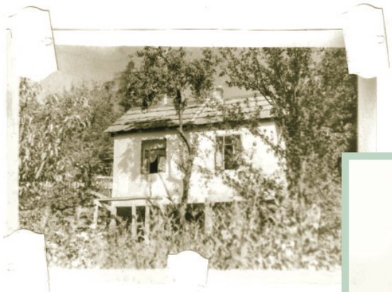
Туапсе. Новый дом А.И. Сызько на бетонных опорах
